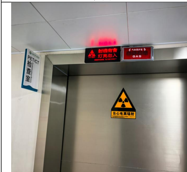
电离辐射警告标志及工作状态指示灯
